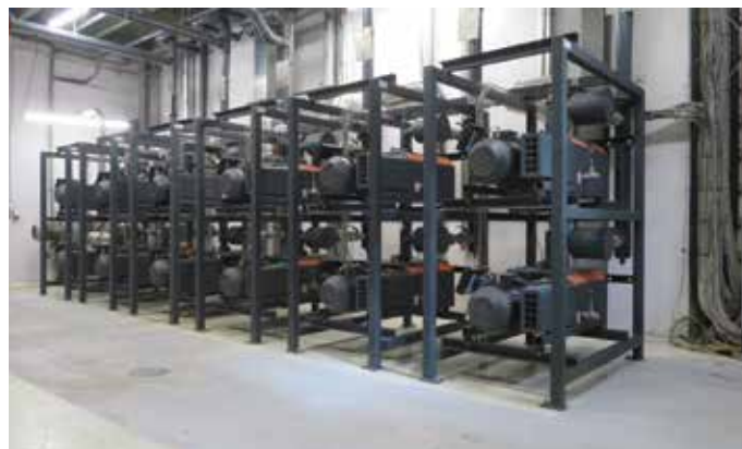
Centralização do fornecimento de vácuo
