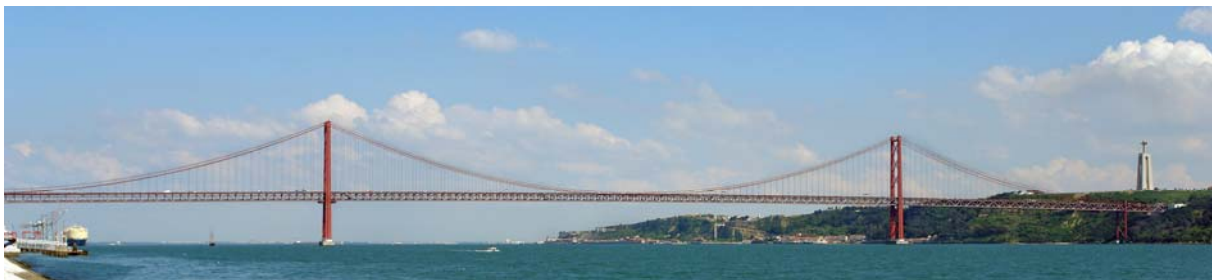
Figura 4 – Ponte 25 de Abril: vista geral
