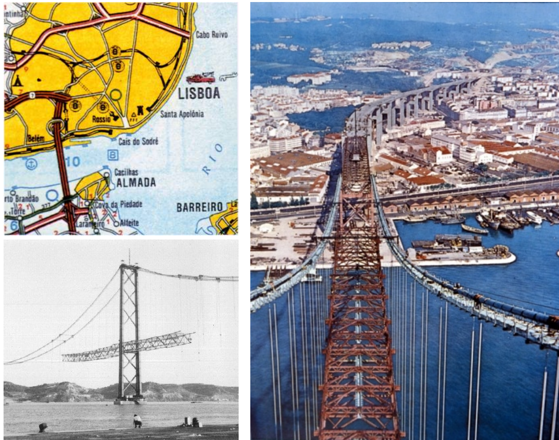
Figura 3 – Ponte 25 de Abril: fases de construção
